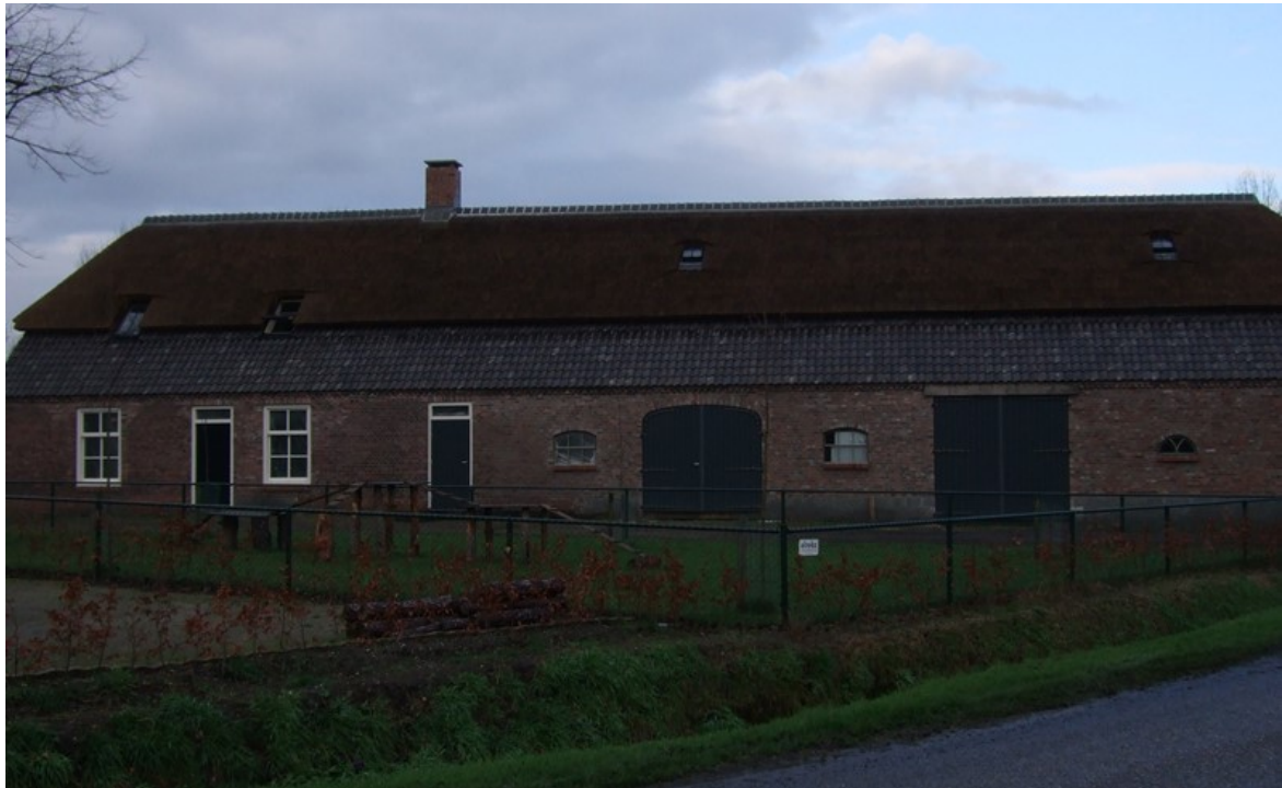
Figuur 3. Aanzicht Hilakker 10A vanuit het zuiden.
