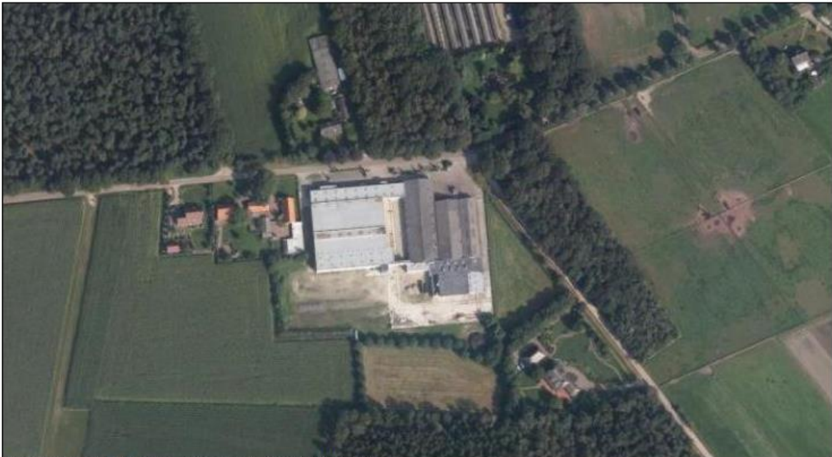
Figuur 1: Luchtfoto bestaande situatie (bron: PDOK.nl)
