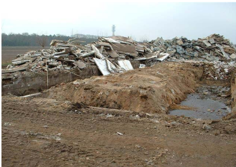
De bedrijfsbebouwing aan De Bleek-Leeuwerikweg is inmiddels gesloopt
