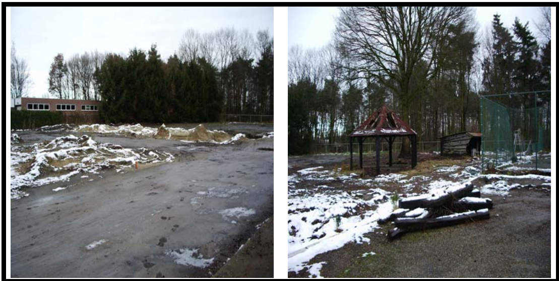
Figuur 3.1 Overzicht van het noordelijke plangebied (25-11-2008). De linker foto toont het noordwestelijke plangebied met het voormalige bedrijfsterrein. De bulten zand tonen de twee plekken met de gesloopte voormalige bedrijfsgebouwen en het verwijderde parkeerterrein. De rechter foto is genomen op het noordoostelijke deel van het plangebied. Het toont het braakliggende tennisveld.
