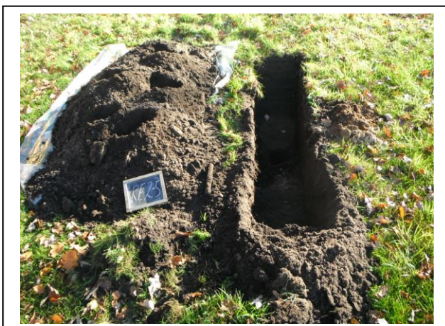
Foto 11. Asbestinspectiesleuf RE2-5
