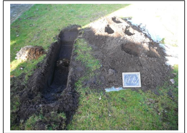
Foto 8. Asbestinspectiesleuf RE2-2
