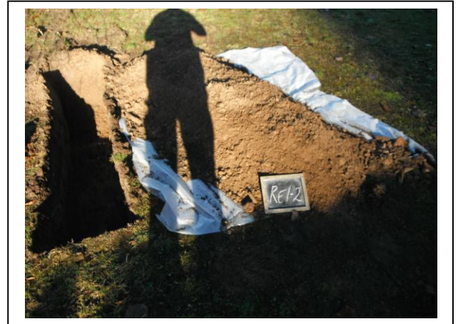
Foto 2. Asbestinspectiesleuf RE1-2
