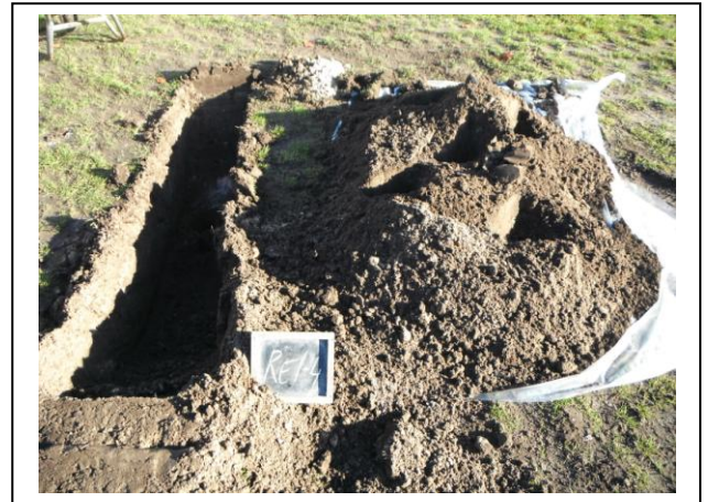
Foto 4. Asbestinspectiesleuf RE1-4
