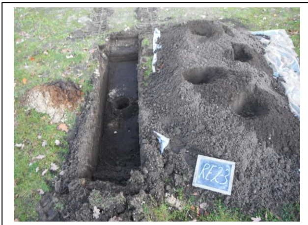
Foto 9. Asbestinspectiesleuf RE2-3
