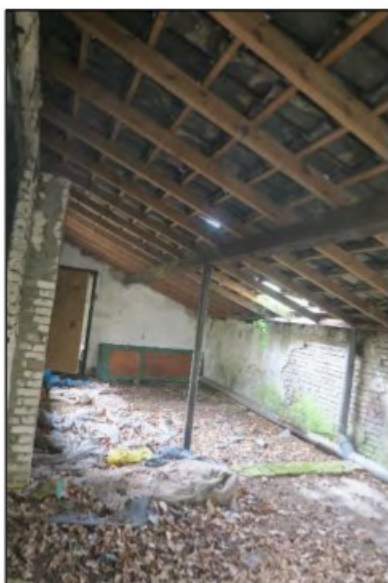
Foto 7. Binnenkant van een van de schuurtjes
