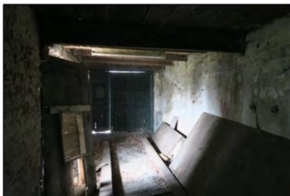
Foto 5. Binnenkant van een van de schuurtjes
