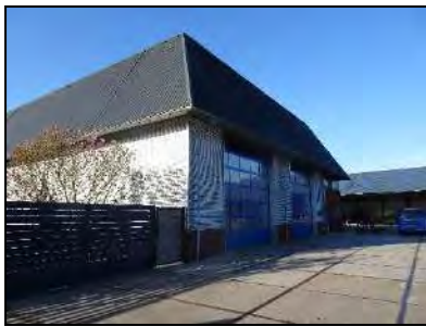
Figuur 3. Loods op zuidwestelijk deel van onderzoekslocatie.
