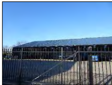
Figuur 4. Loods op westelijk deel van onderzoekslocatie.
