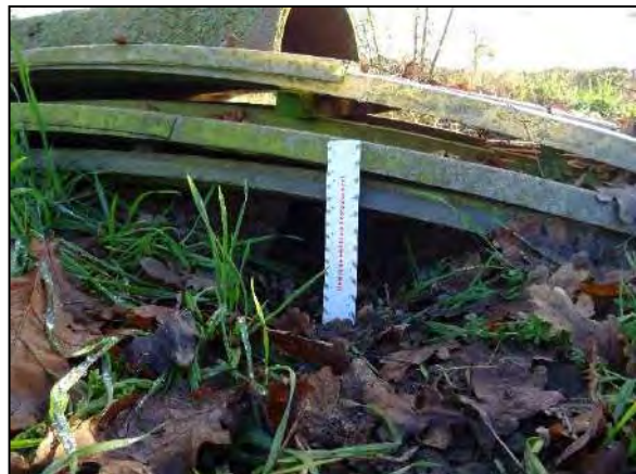
Figuur 17. Rommelig hoekje op het perceel met oude dakplaten.
