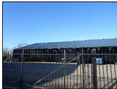
Figuur 4. Loods op westelijk deel van onderzoekslocatie.
