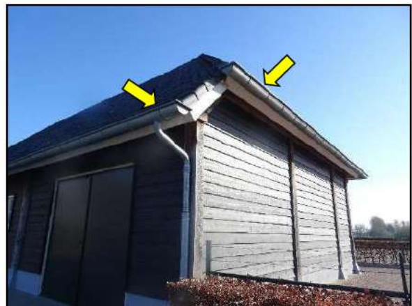
Figuur 16. Toegang naar ruimtes onder de dakpannen voor huismus via de dakgoot (bijgebouw op perceel woonhuis).
