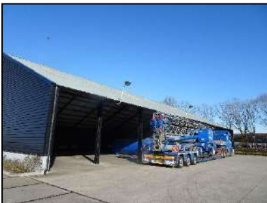
Figuur 6. Loods op westelijk deel van onderzoekslocatie.
