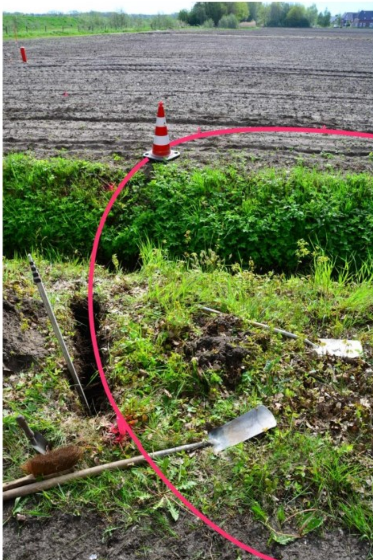
foto 9 Situatie bij kuil 1
