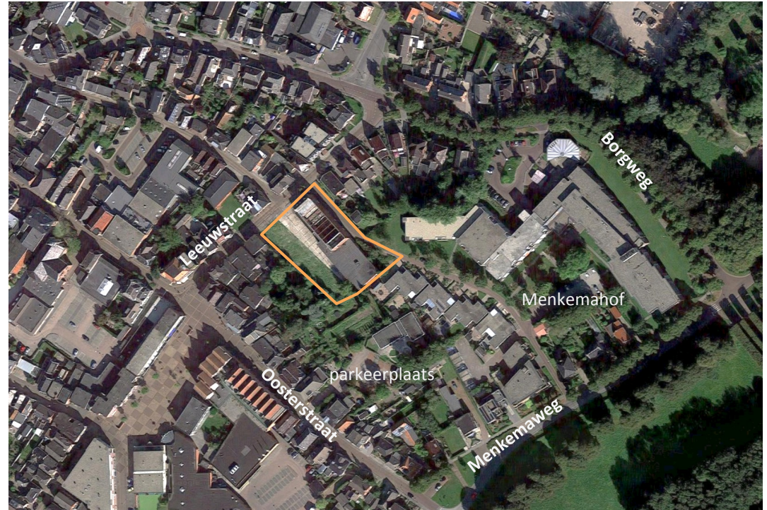
Het grote bouwblok, met de ontwikkelingslocatie; het inmiddels afgebroken City theater is nog zichtbaar
