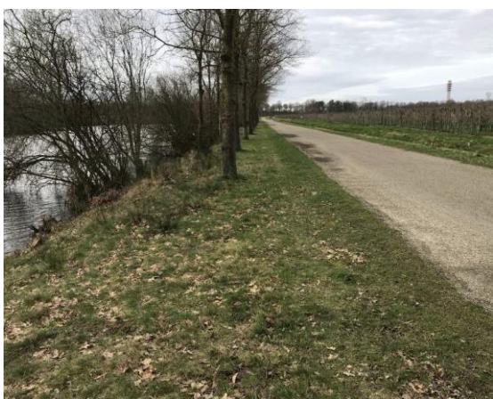
Afbeelding 0.10. Het deel van de Rietkamp waaraan op de foto links van de weg bermversteving plaats zal vinden. Foto genomen in zuidwestelijke richting.
