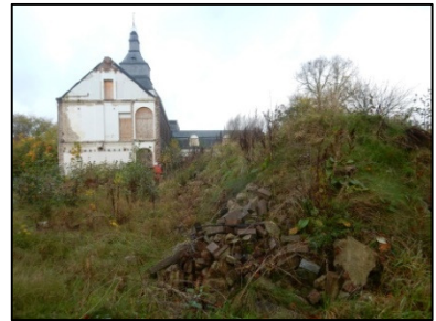
Figuur 5. Puinresten ter plaatse van voormalige bebouwing.
