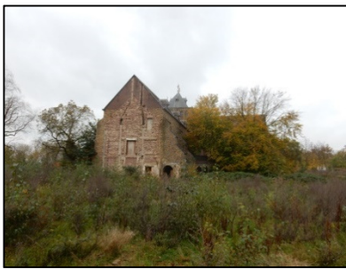
Figuur 7. Oostgevel kapel.
