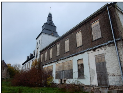
Figuur 6. Zuidgevel chateau Horin afgetimmerd met plaatmateriaal.
