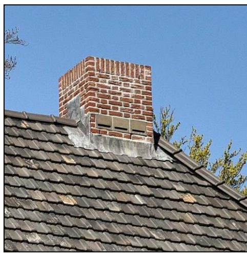
Figuur 14. Inbouwkast vleermuizen (type: IB VL 01 Vivara). Figuur 15. Inbouwkast vleermuizen in schoorsteen.
