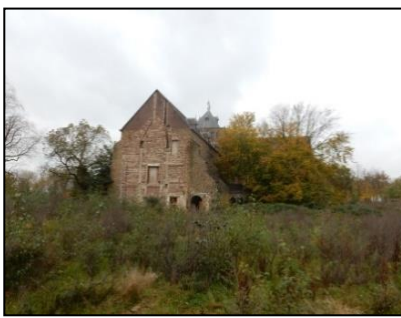
Figuur 7. Oostgevel kapel.
