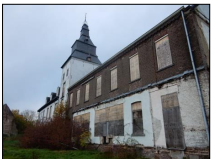
Figuur 6. Zuidgevel Chateau Horin afgemmerd met plaatmateriaal.
