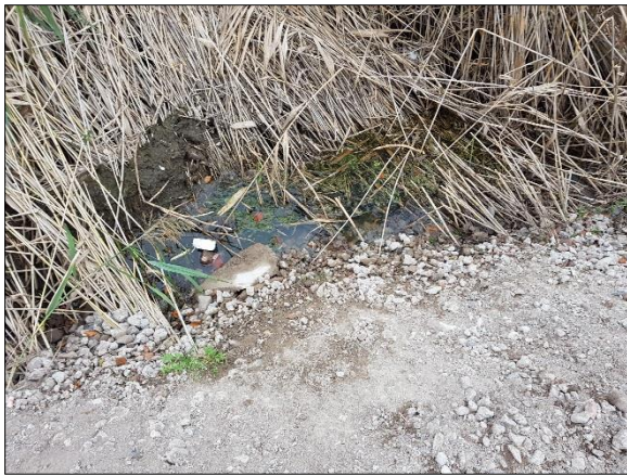
Figuur 7. Detail sloop noordzijde plangebied naast oprijt
