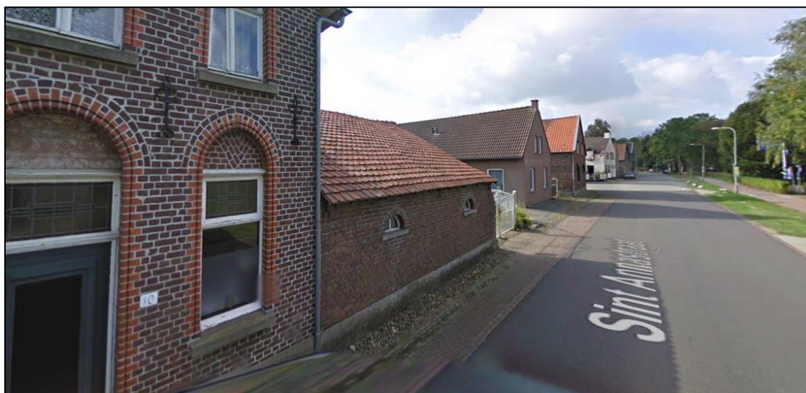
Vooraanzicht vanaf linkerzijde Sint Annastraat (nr. 11 is schuur naast woning op de voorgrond)
