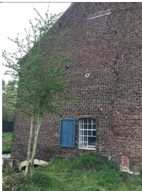
Linker zijgevel met venster in woonkamer en dichtgemetseld venster op bovenverdieping
