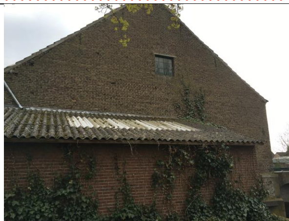
Rechter zijgevel met kantoorruimte (onder)
