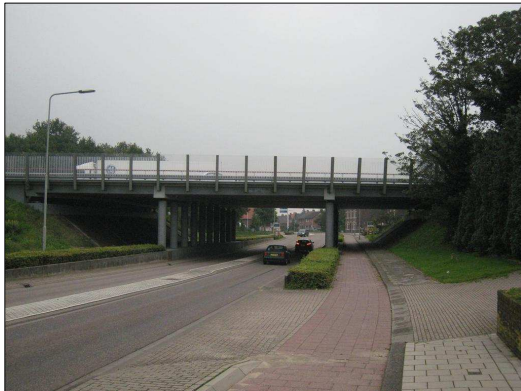
De Kloosterstraat, met zicht op het viaduct van de kruisende Rijksweg A2.
