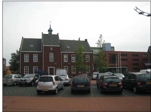
Parkeervoorzieningen op de Markt in Maasbracht, met op de achtergrond het gemeentehuis.
