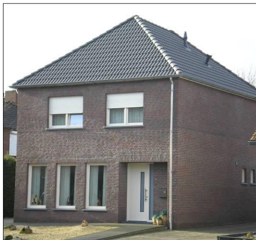
nieuwbouw aan de Eindstraat
