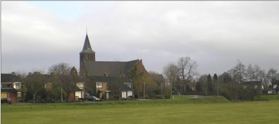
waterkeringing aan de kernrand in de vorm van verhoging
