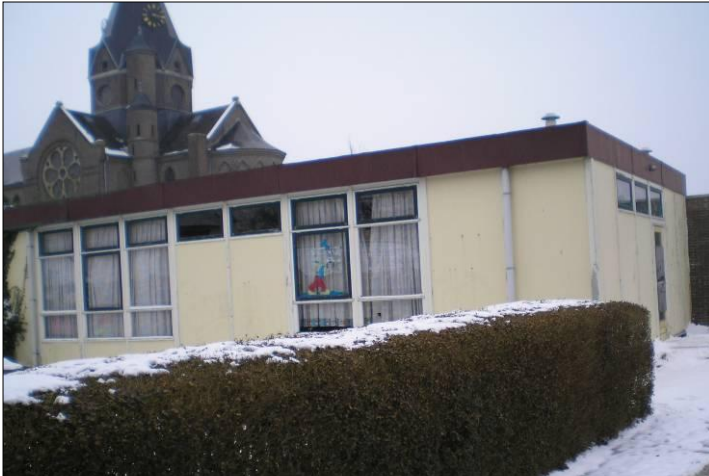
tijdelijk schoolgebouw aan de rand van de kern Ohé
