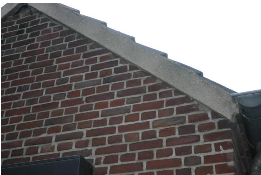
Figuur 4.2.2. De ruimte onder de dakpannen van de langgevelboerderij is op de kapse kanten afgedicht met specie.
