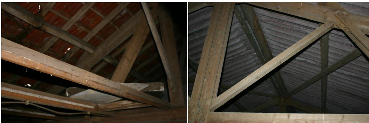
Figuur 4.2.3. Zowel het pannendak (l) als het golfplaten dak (r) van de oude grupstal is volledig enkelwandig.
