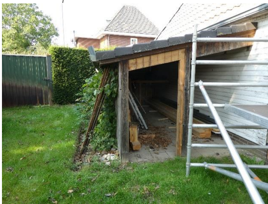
Afbeelding 4. Te slopen houten schuurtje met dakpannen en open aan de zijkant.
