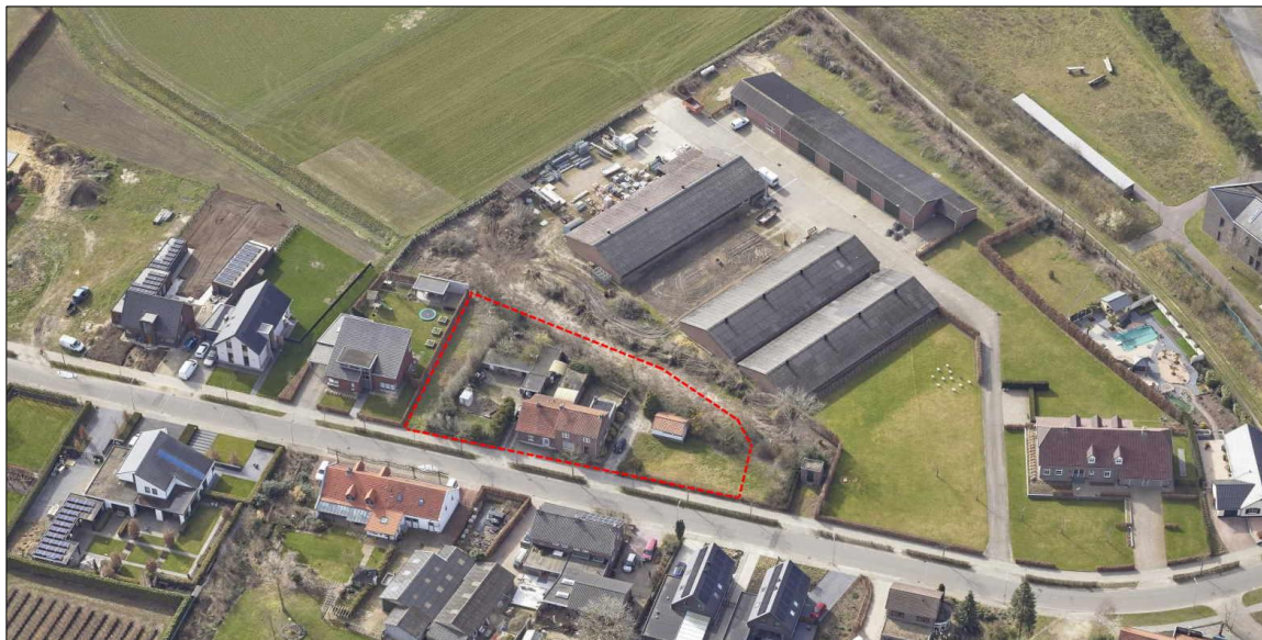
Zicht op de projectlocatie erf, kijkend in zuidelijke richting
