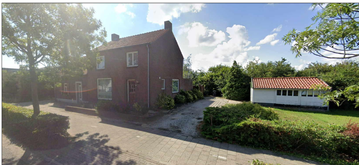
Zicht op de locatie Walk 14 vanaf de straat (Bron: Google Streetview, september 2020)
