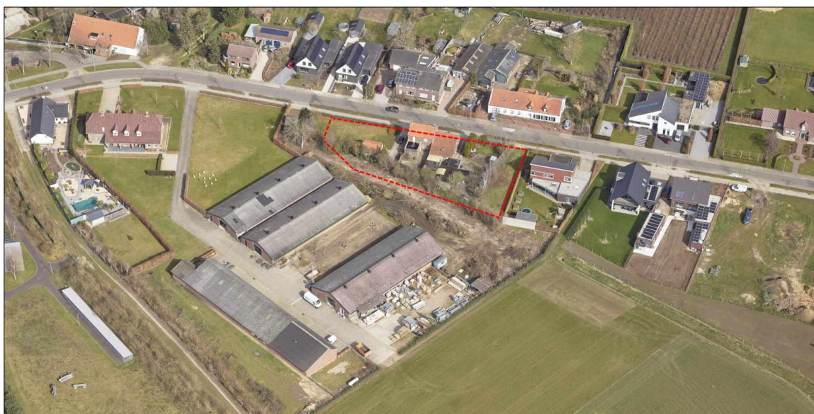
Zicht op de projectlocatie erf, kijkend in noordelijke richting
