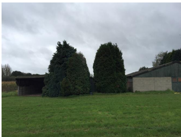
Foto loods (3) en hooiopslag (1)
