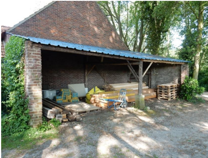
Achteraanbouw aan de westelijke schuur
