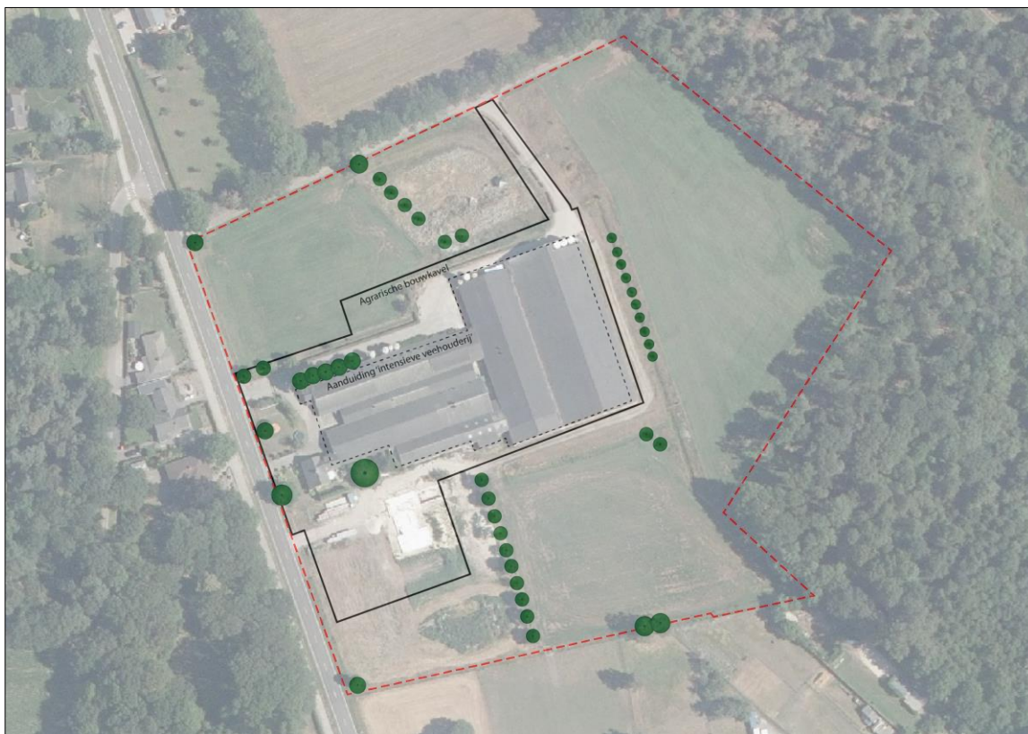
Luchtfoto bestaande situatie
