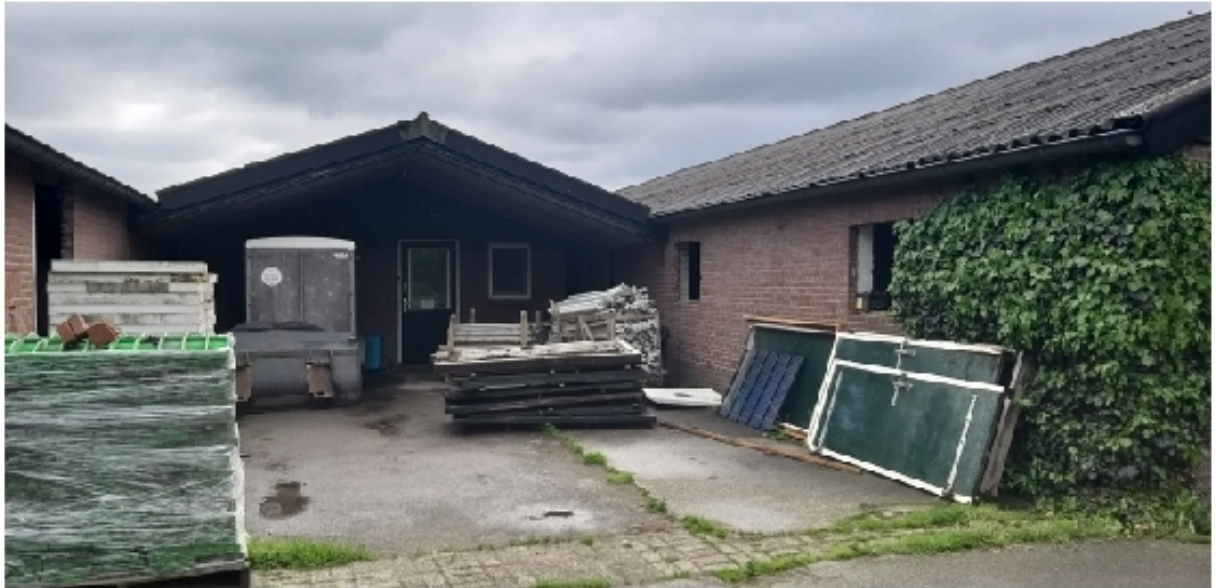
Foto 5: Impressie van de te slopen stallen (4)
