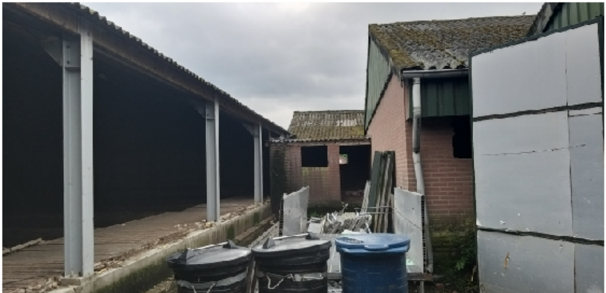
Foto 2: Impressie van de te slopen stallen (1)
