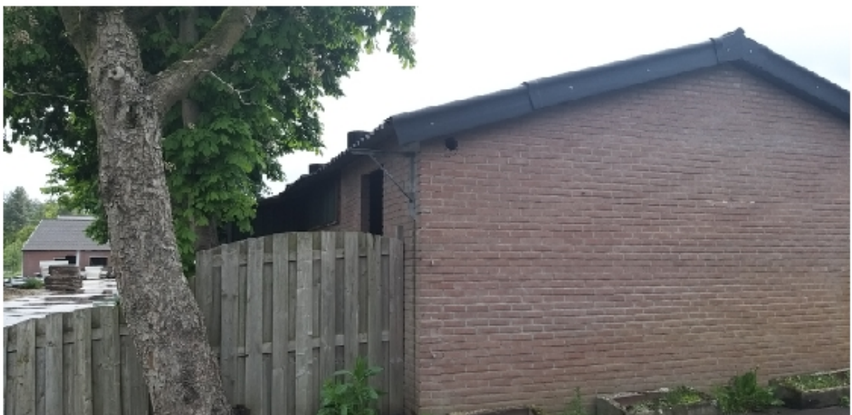
Foto 4: Impressie van de te slopen stallen (3)
