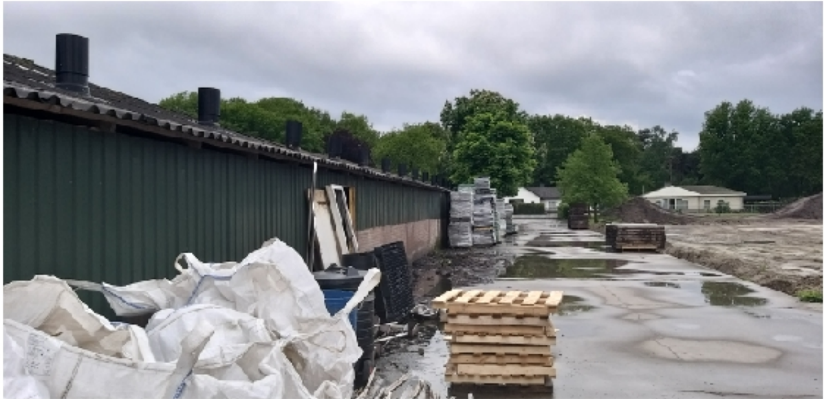
Foto 3: Impressie van de te slopen stallen (2)
