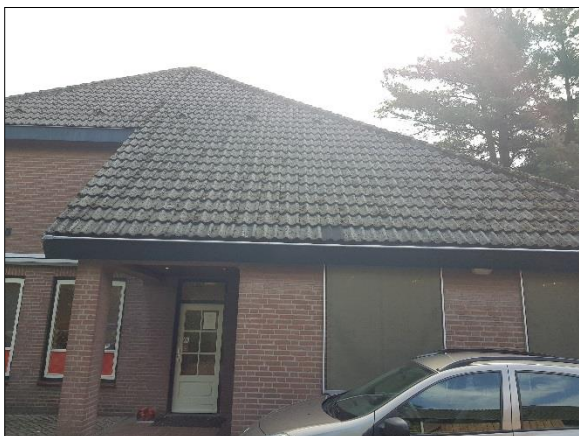
Figuur 6. Kantoorgebouw gezien vanaf westen
