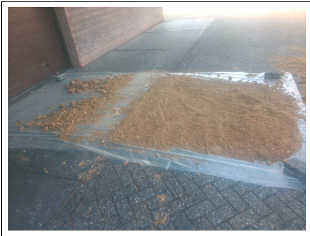
Foto 9. Opgegraven en geharkt (bodem)materiaal sleuf 05
