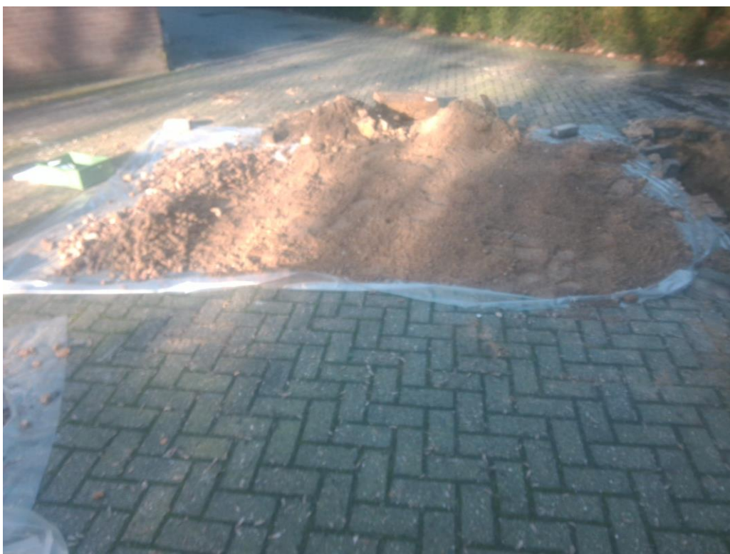
Foto 17. Opgegraven en geharkt (bodem)materiaal sleuf 08
