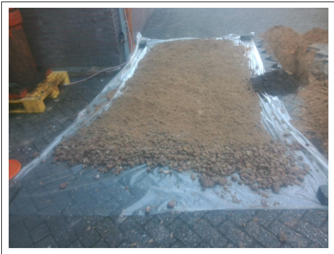
Foto 13. Opgegraven en geharkt (bodem)materiaal sleuf 07
