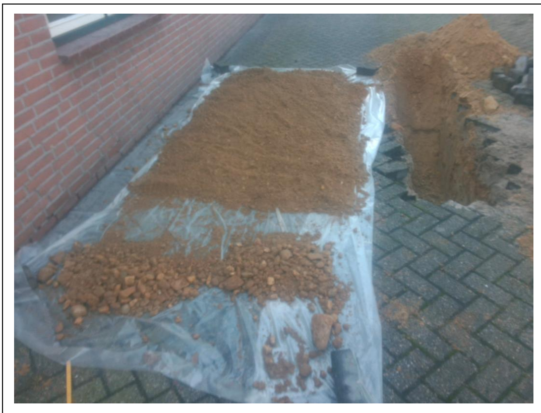
Foto 11. Opgegraven en geharkt (bodem)materiaal sleuf 06
