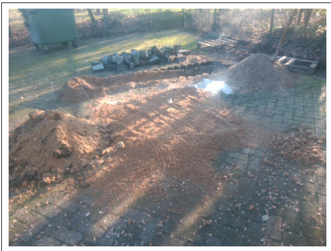
Foto 22. Opgegraven en geharkt (bodem)materiaal sleuf 10
