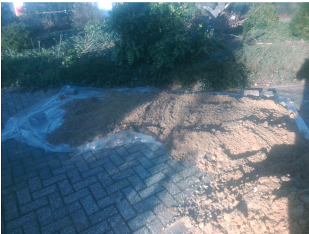
Foto 2. Opgegraven en geharkt (bodem)materiaal sleuf 02
