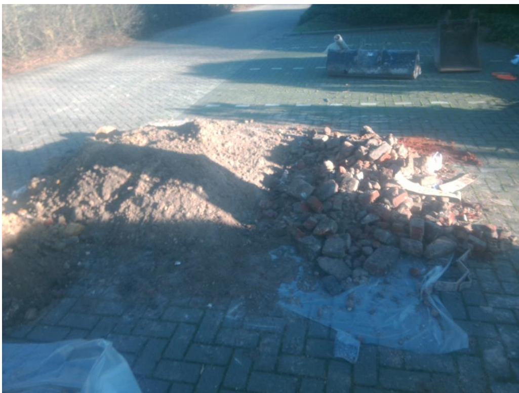
Foto 4. Opgegraven en geharkt (bodem)materiaal sleuf 03
