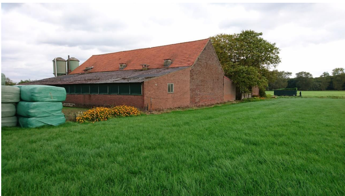
Figuur 4: de oude stal met zijdelingse aanbouwen vanaf het zuidwesten gezien
