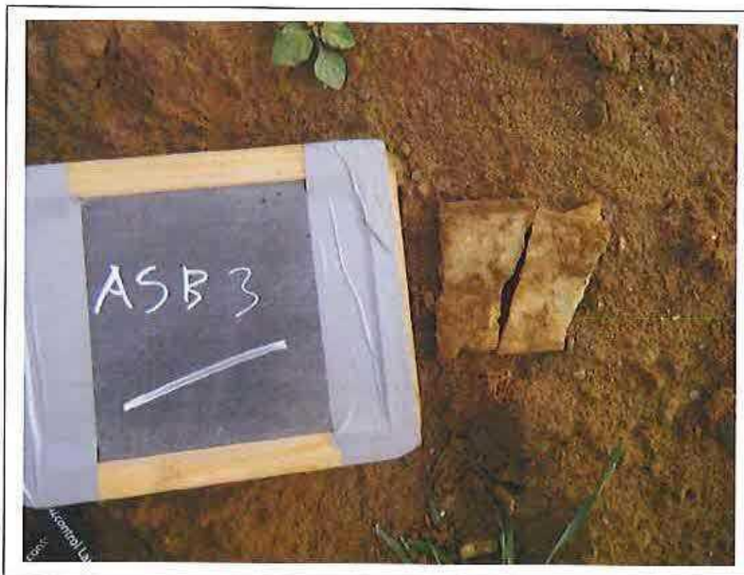
ASB-3. Vindplaats asbesthoudend vlak plaatmateriaal
