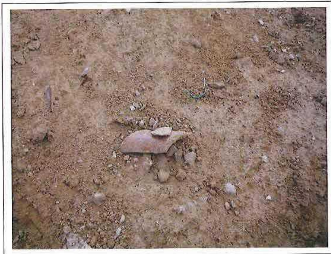
ASB-2. Vindplaats asbesthoudend gresbuis
