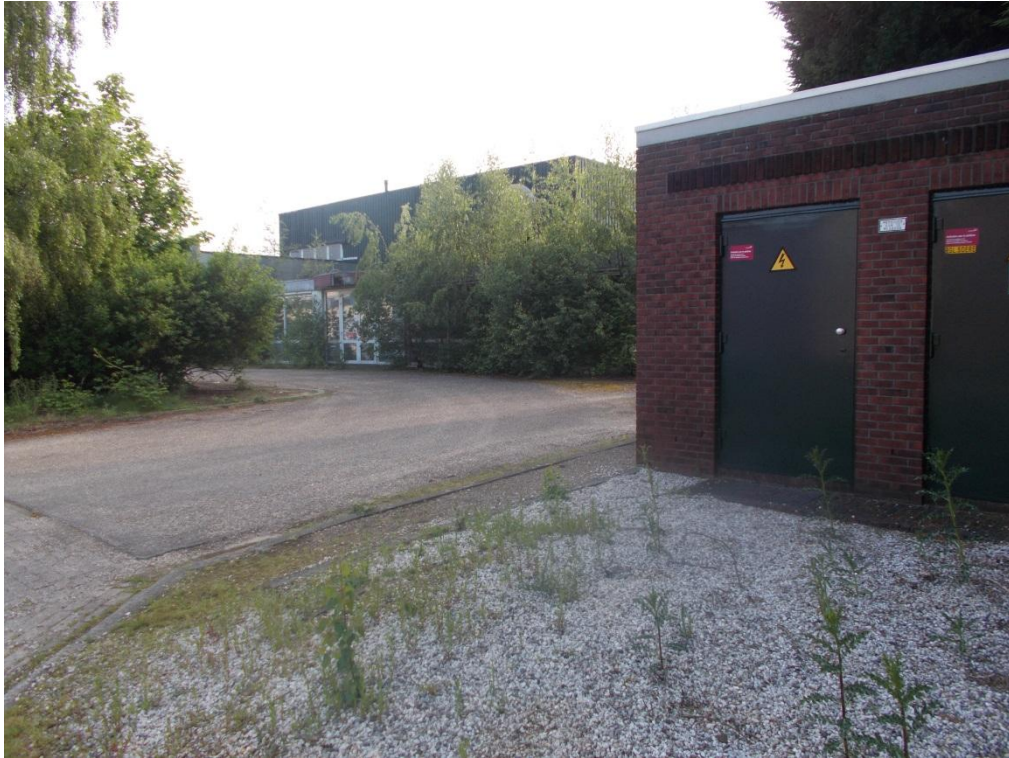
Foto 5: Onderzoekslocatie Hanssum (perceel M735, met aan voorzijde het transformatorstation)
