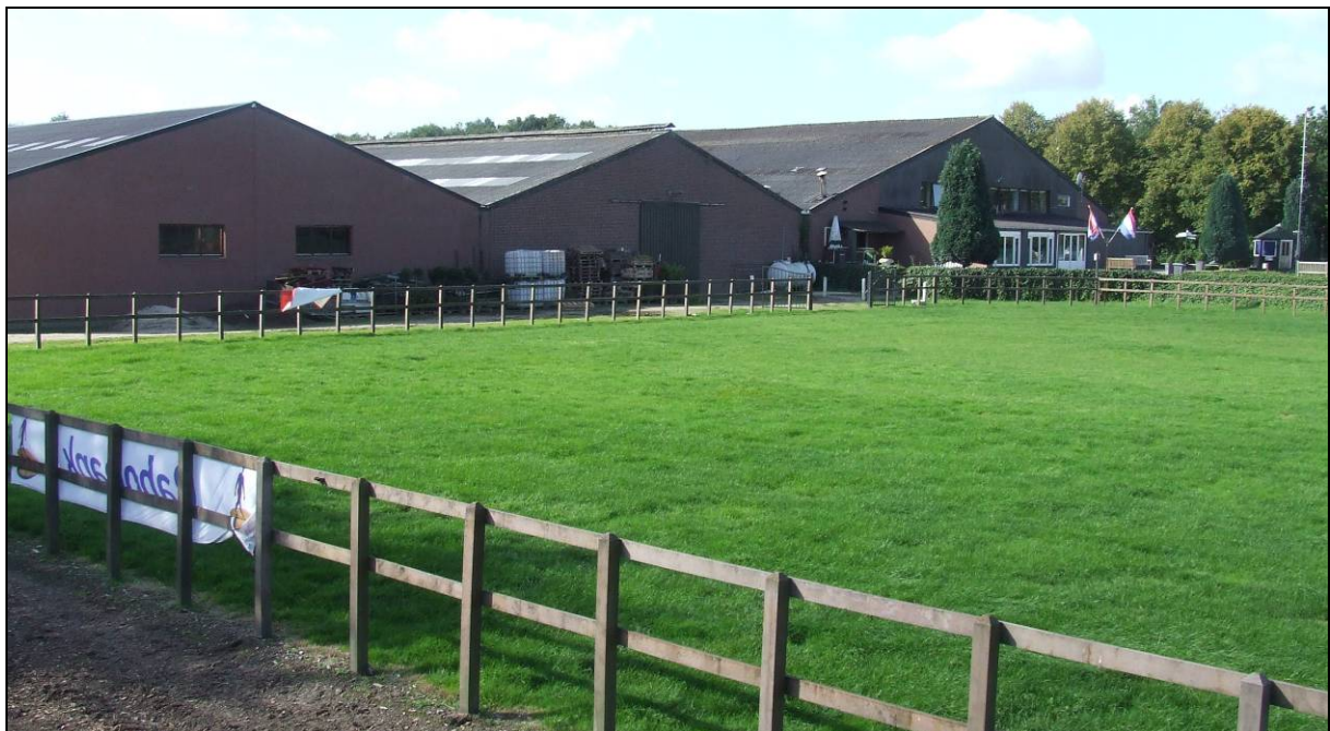
Figuur 10: Centrale deel van het plangebied gezien vanaf boring 39 in zuidwestelijke richting met de bedrijfsgebouwen.
