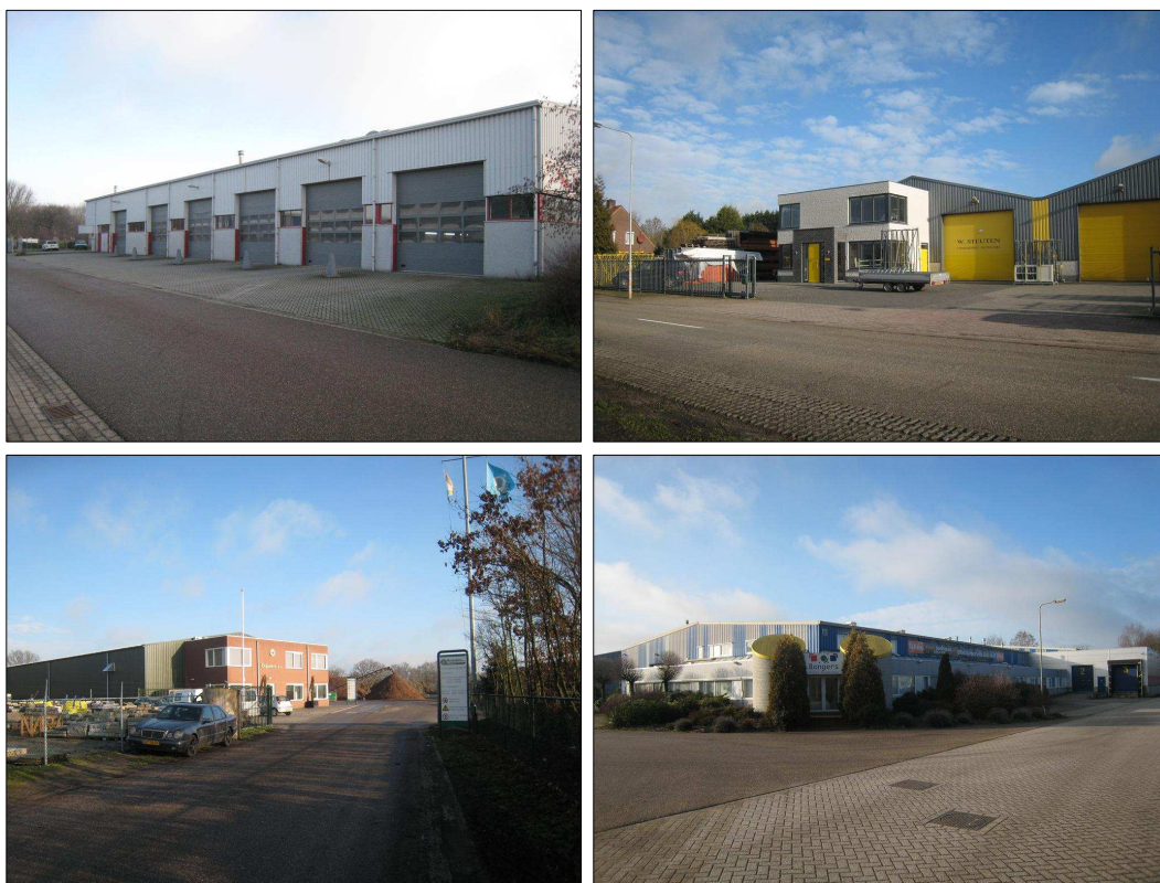
Afbeelding 18 t/m 21. Bedrijfsbebouwing op het bedrijventerrein Kelperheide.
