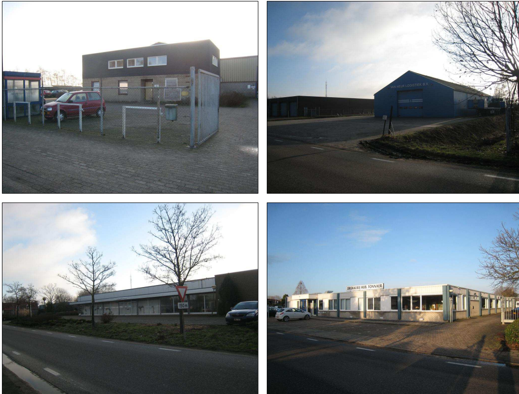
Afbeelding 14 t/m 17. Bedrijfsbebouwing op het bedrijventerrein Ellerweg.
