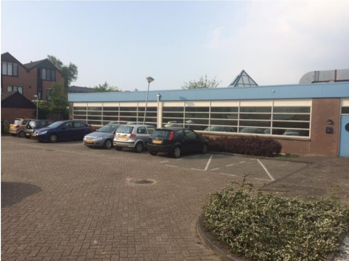
Afbeelding 3.2: Huidige situatie projectgebied zicht op zuidwestelijke zijgevel met parkeerplaats (bron: KuiperCompagnons, augustus 2016).
