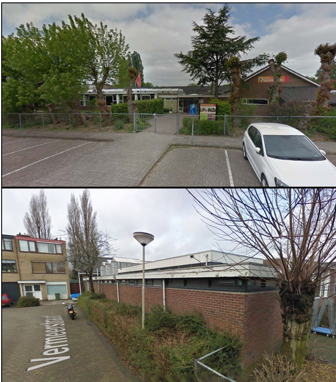
Afbeelding 6: Zicht op huidig schoolgebouw vanaf Rembrandtlaan (boven) en Vermeerstraat (onder).
