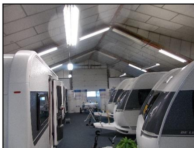
Figuur 5. Binnenkant van gebouw 2 Bron: NWC
