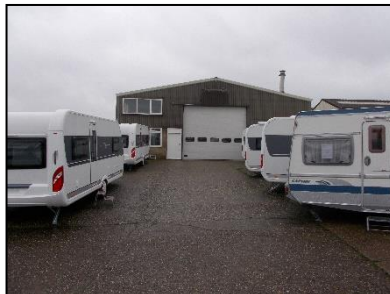
Figuur 1. Overzichtsfoto van gebouw 1. Bron: NWC
