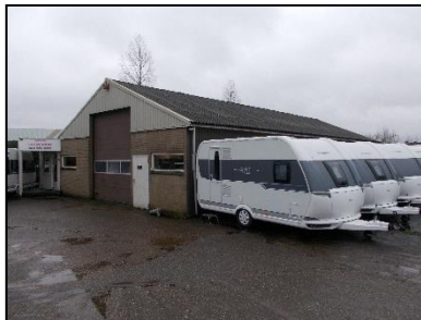
Figuur 2. Overzichtsfoto van gebouw 2. Bron: NWC
