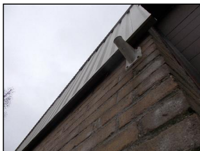
Figuur 4. Detailfoto golfplaten tegen gevel gebouw 2. Bron: NWC
