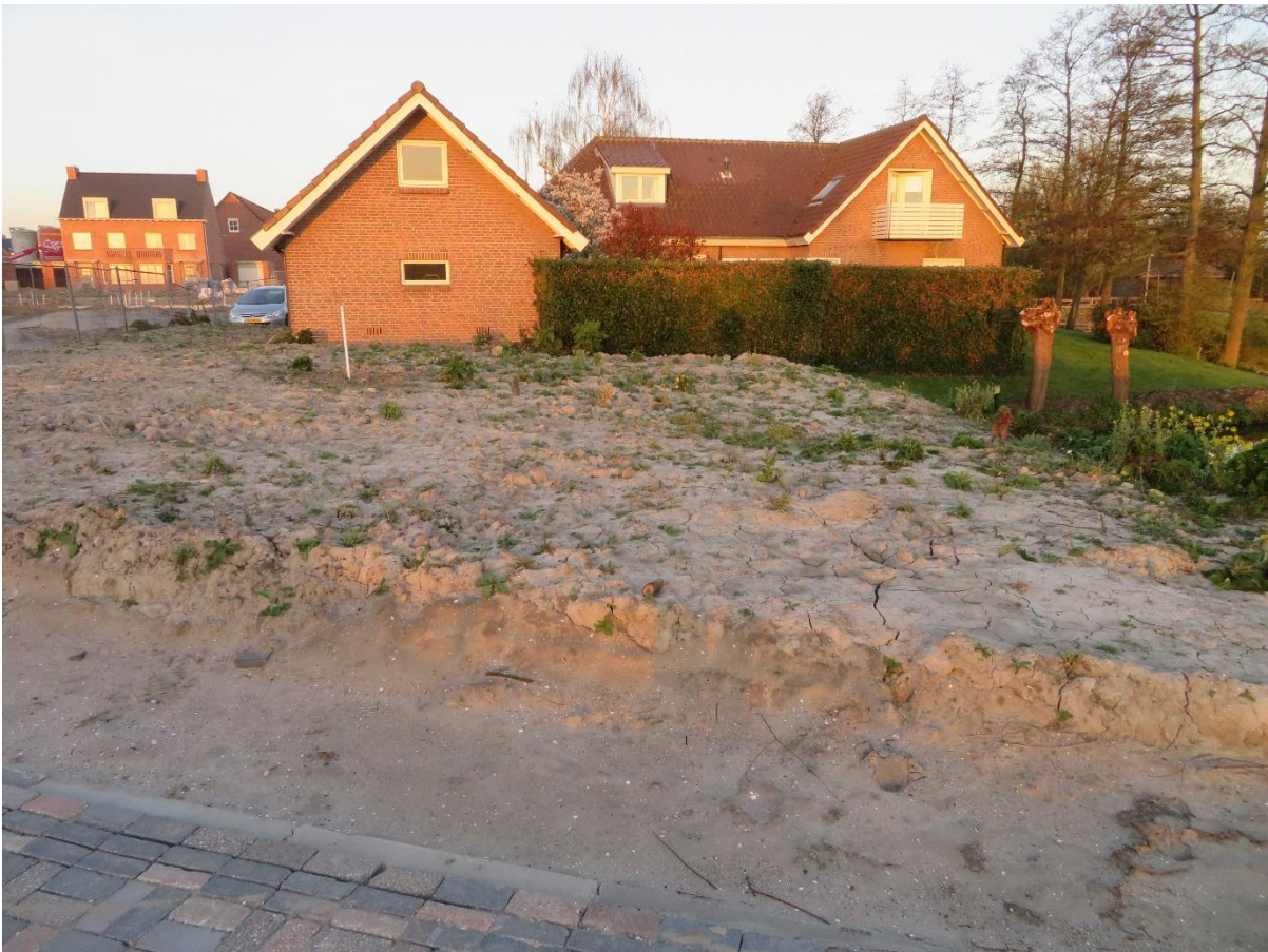
Werkzaamheden ten behoeve van woningbouw naast het plangebied.
