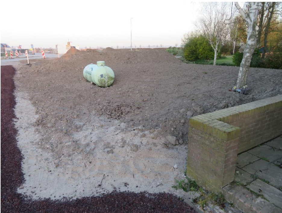
Foto-impressie locatie woning 3: reeds bouwrijp gemaakte grond.
