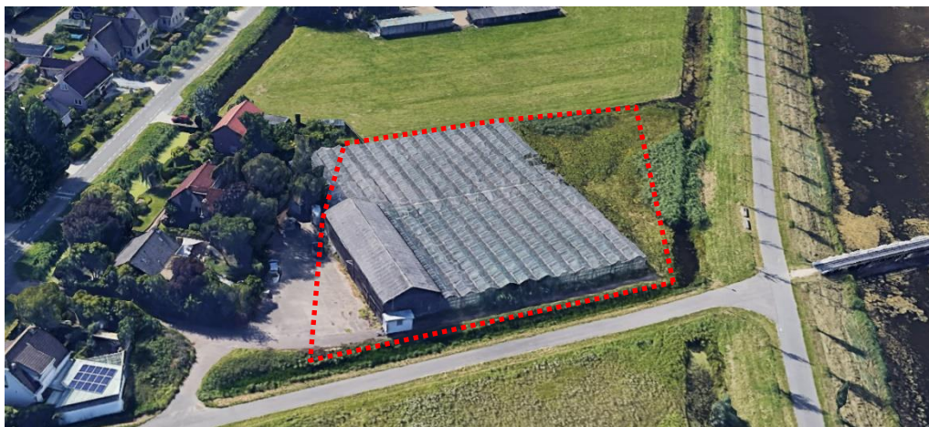
Luchtfoto huidige situatie plangebied (rood), gezien vanaf het noorden (bron: Google Earth)
