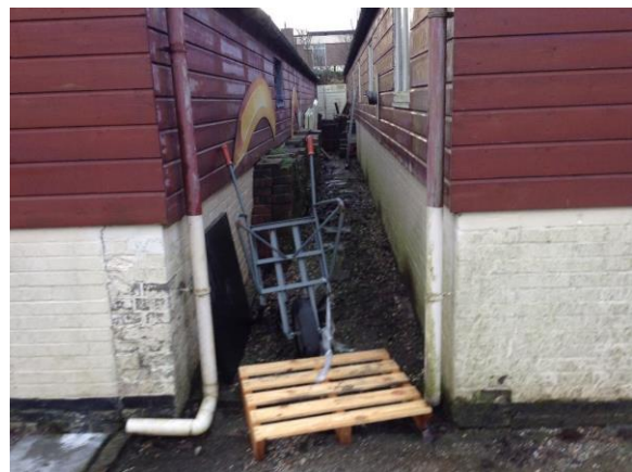
Figuur 7: Dak(goot) bebouwing
