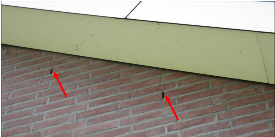
Foto 3: Spouwgangen in schuur die grenst aan het plangebied
