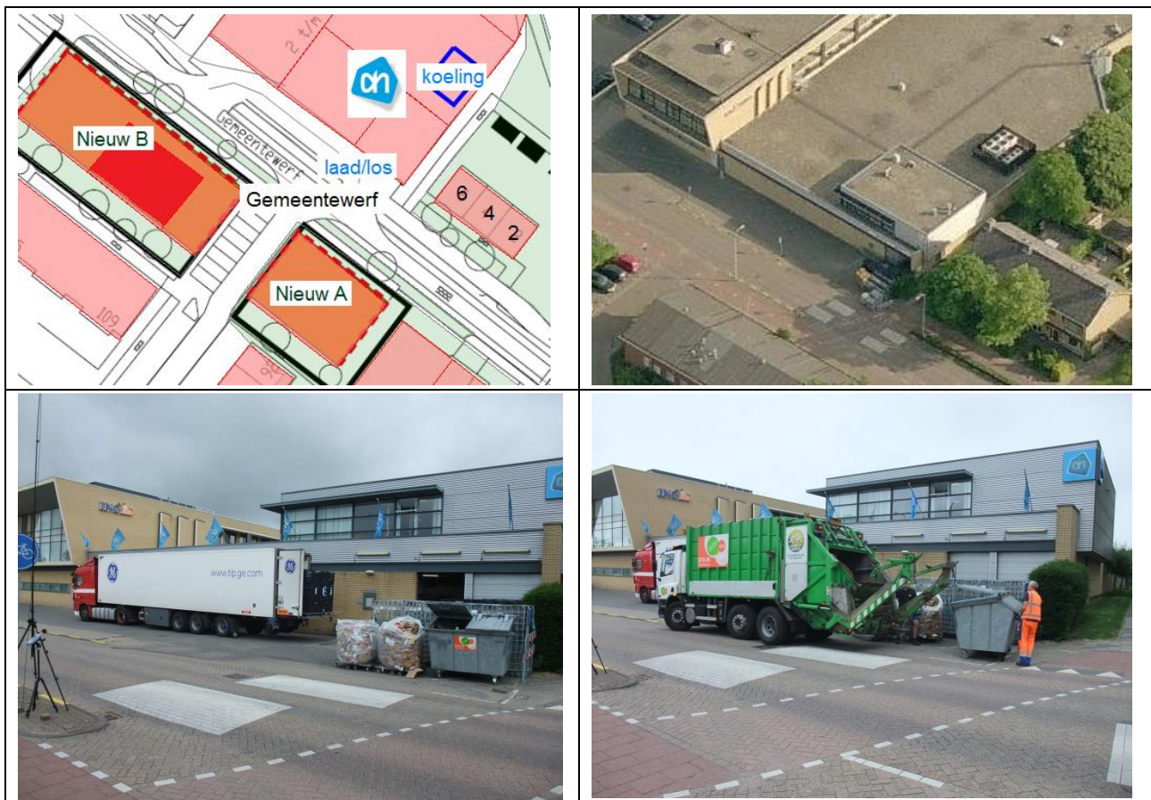
Figuur 2 Overzicht situatie laad/loslocatie Albert Heijn met locatie koeling (rechtsboven), lossen van rolcontainers (linksonder) en ophalen afval (rechtsonder).
