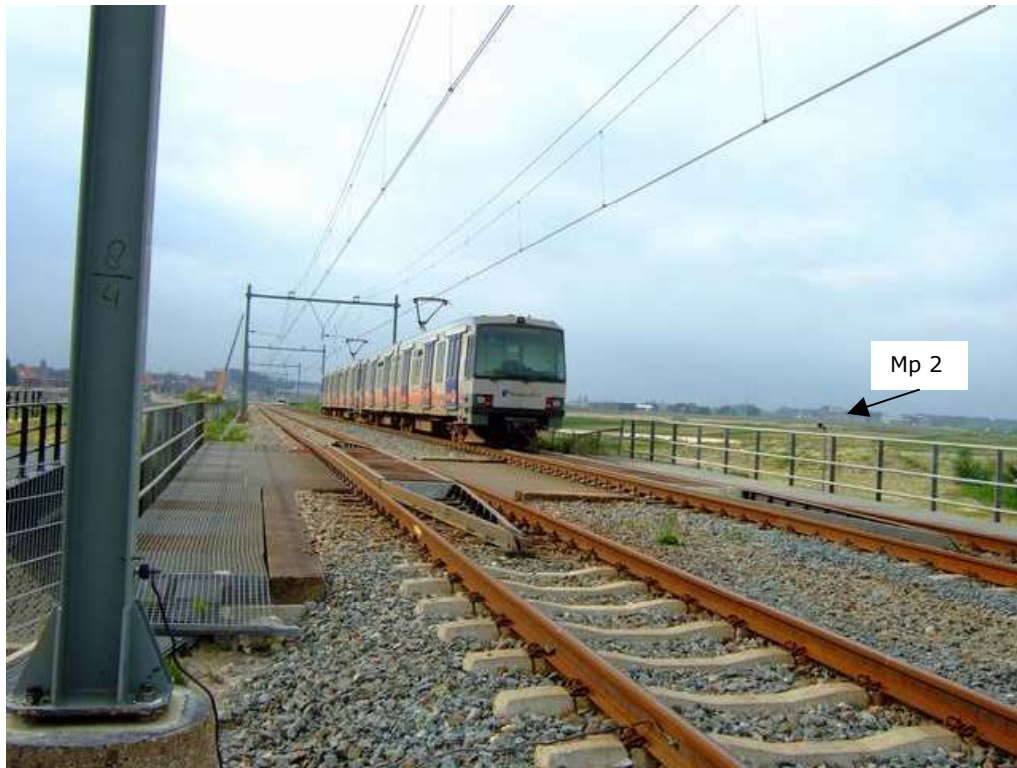
Foto 1: SG 2 ter hoogte van stalen brug
