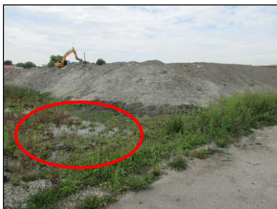
Foto 7: Ondiepe plassen (rood omcirkeld) en zandhopen
