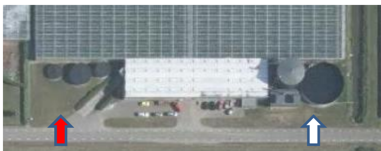
Bovenaanzicht straatzijde: witte pijl: silo's, rode pijl: onbebouwd terrein
