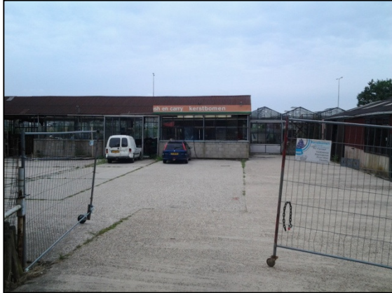
Foto 1: Buiten terrein ingang
