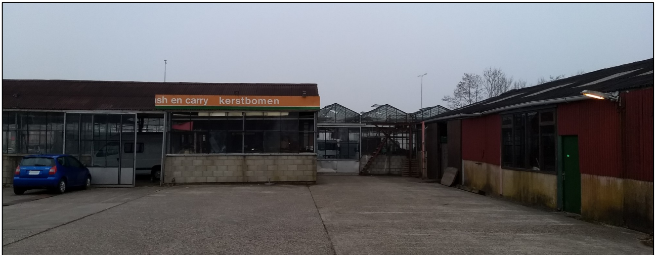
Figuur 2. Situatie terrein op 26 maart 2018: kassencomplex en golfplaten schuur (rechts).
