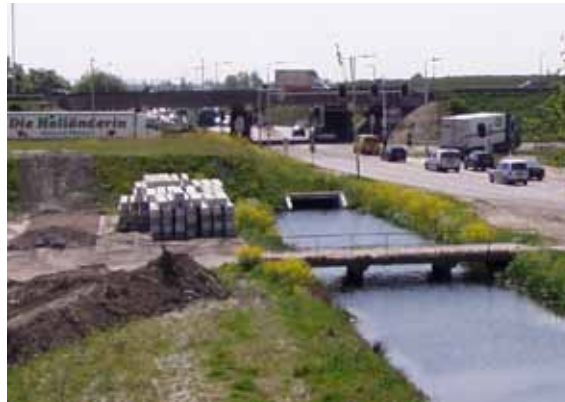
Werkzaamheden aan de nieuwe aansluiting op de A12
