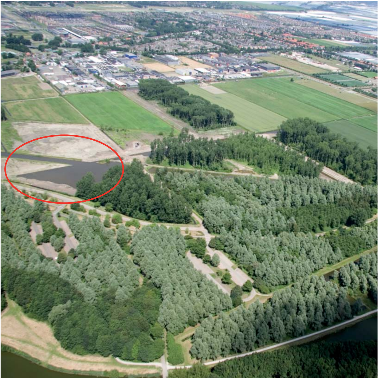
Luchtfoto locatie recreatief concentratiepunt
