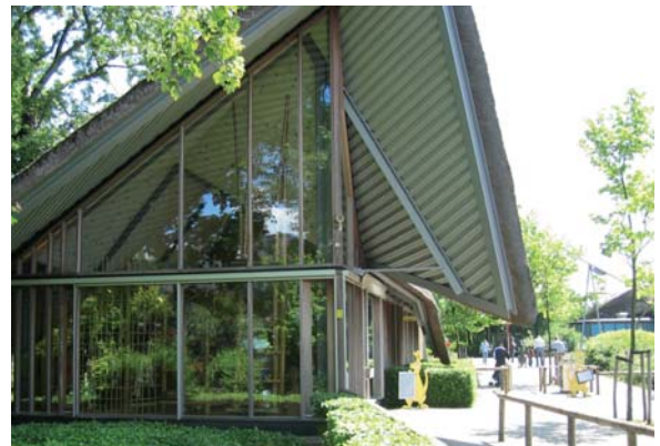
Referentiebeelden , materiaalgebruik, overkapping
