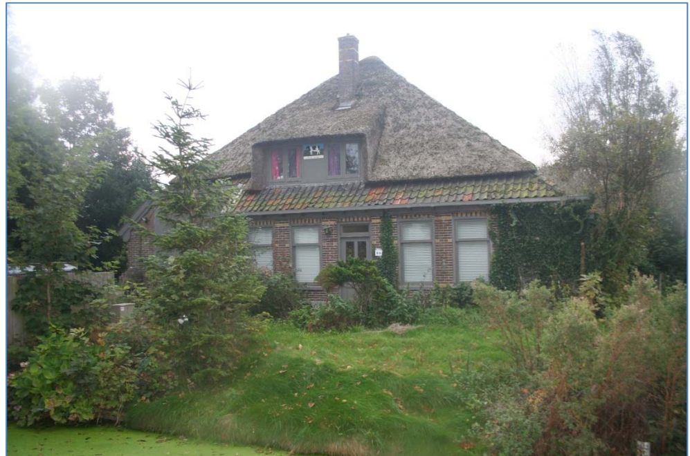
De bestaande stolp in het plangebied zal worden genoveerd.
